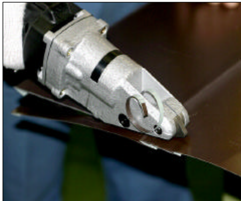
横葺成型材の切断
