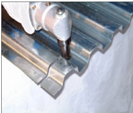
キーストンプレートの切断
