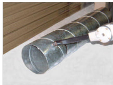
スパイラルダクトの切断
